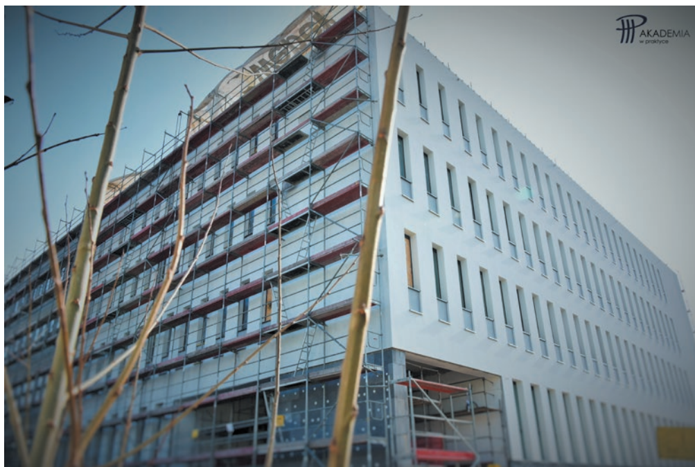
Fot.: Budowa budynku Sądu w Nowym Sączu (2016), źródło: Warbud S.A.
