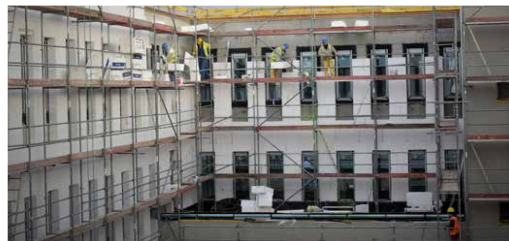
Fot.: Budowa budynku Sądu w Nowym Sączu (2016), źródło: Warbud S.A.
