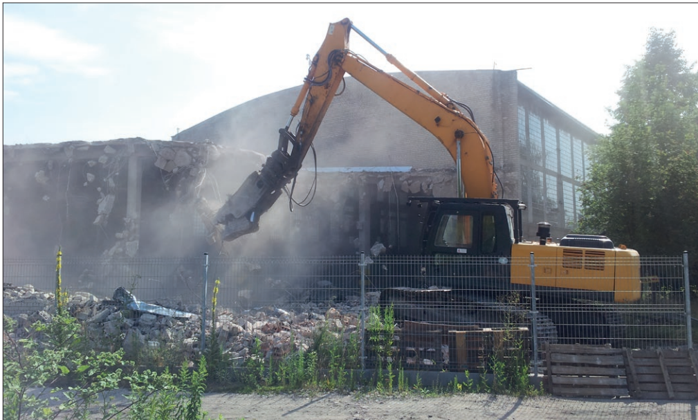
Wyburzenie hali oczyszczania wstępnego i obróbki osadów starej oczyszczalni, źródło: Saur Konstancja
