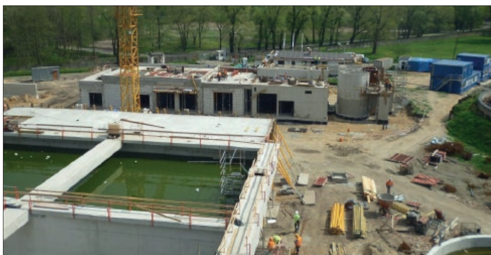
Oczyszczalnia ścieków w trakcie modernizacji. Źródło: Saur Konstancja
