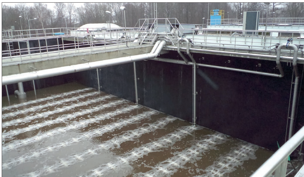
Próba sprawności rusztów napowietrzających w reaktorach SBR, źródło: Saur Konstancja
